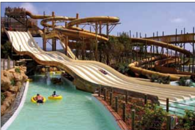
La seguridad debe evaluarse de manera continua en todas las fases de una instalación de ocio acuático: diseño, ingeniería, obras, puesta y funcionamiento.
